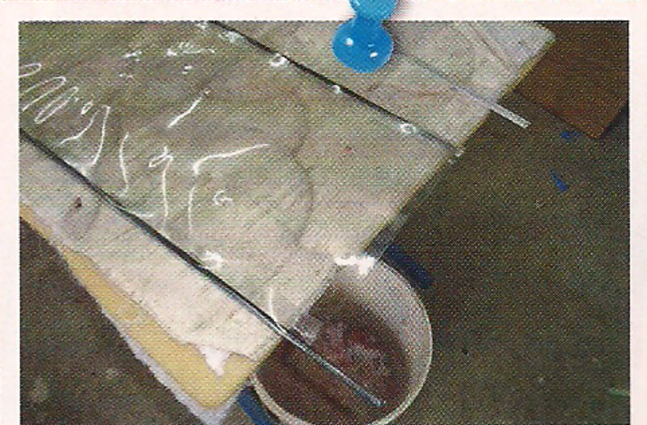
11 - La feuille de PVC qui servira lors de la stratification est équipée des lattes de renfort qui permettront de la tendre.
